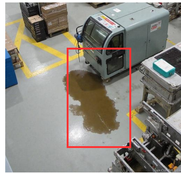
设备漏油/漏水
