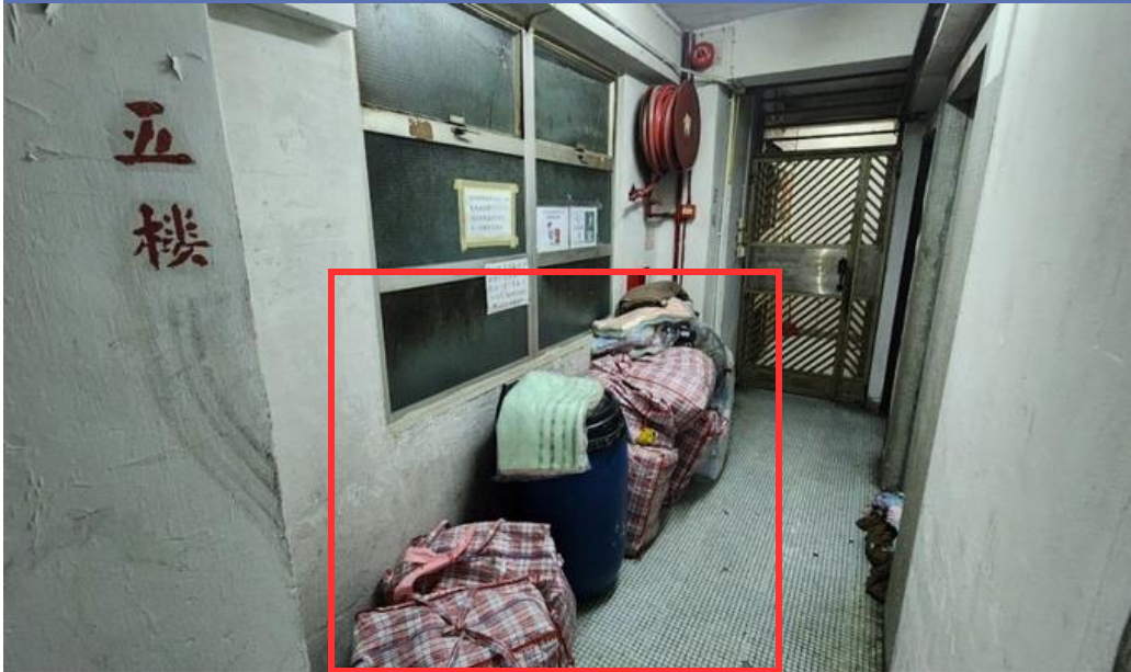
消防通道占用
